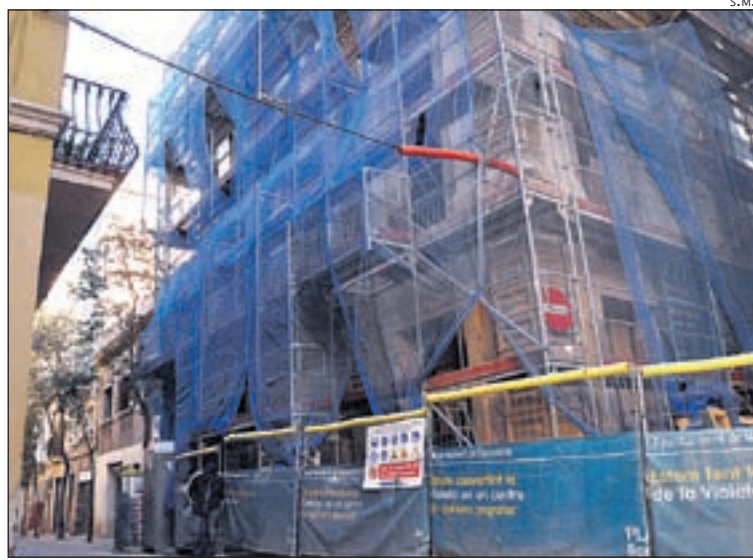
L'EDIFICI DE LA VIOLETA, EN OBRES
